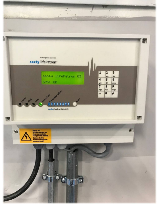
Master Cihaz'ın Uygulaması Alarm Şiddeti 3 cü seviyeye set edilmiş hali.
